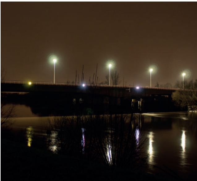
Baanverlichting Vlassenbroekbrug over de Schelde reikt ver daarbuiten. Foto: RLSD
