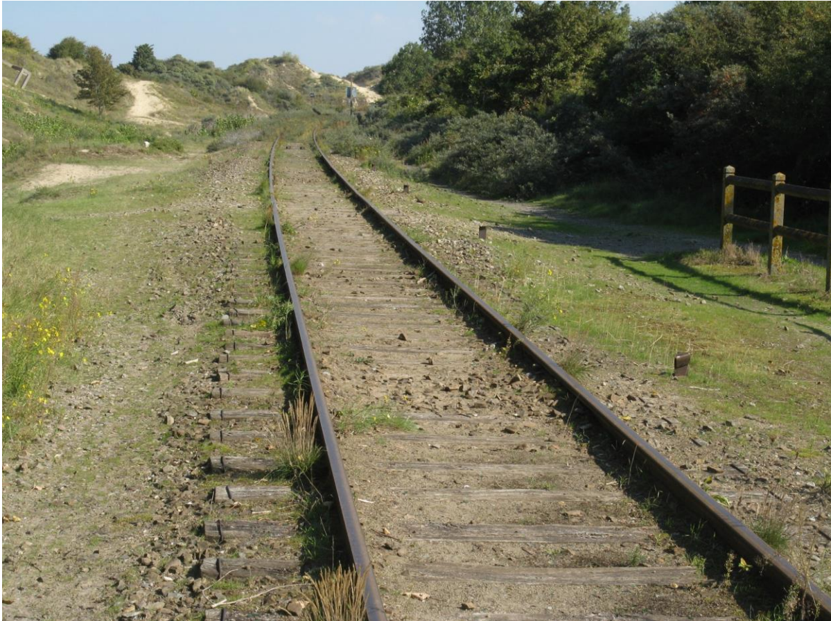
Fig. 6.17. La plate-forme de la voie ferrée de la liaison ferroviaire désaffectée Dunkerque-La Panne peut aussi bien constituer un habitat pour les espèces dunaires sèches que jouer un rôle de corridor écologique. Dans les deux cas, un aménagement et une gestion soignés peuvent optimiser la fonction écologique. Ici aussi, le choix des espèces cibles est essentiel et il est préférable de travailler sur une vision globale. Il faut également examiner dans quelle mesure et comment cette structure peut remplir une fonction récréative.
